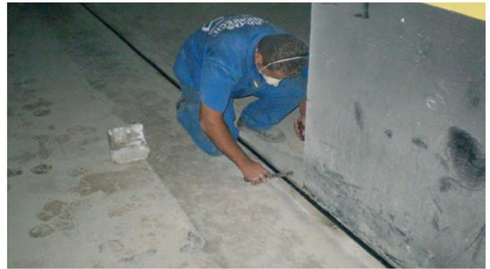
2.1.2. **Juntas de Construção:** São juntas que separam as diversas etapas do processo de concretagem de grandes panos, evitando problemas causados pelos diferentes tempos de secagem [cura] do concreto.
